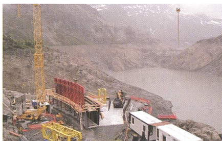
Bild 1. Fertigung des Ein-/Auslaufbauwerkes am Ufer (Foto: SWV/Pfa).
