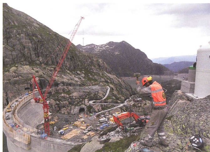
Figure 12. Vue générale du chantier.
