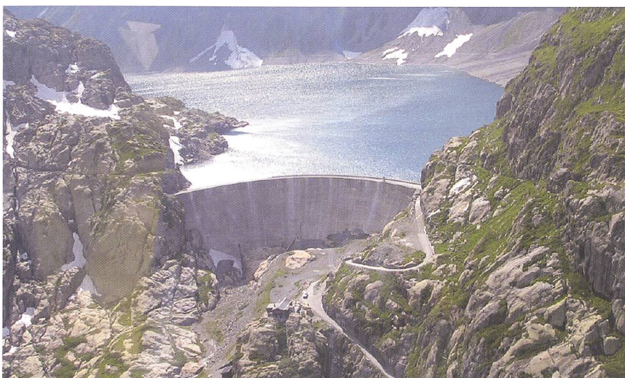
Figure 5. Vue aérienne du barrage du Vieux Emosson.
