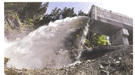
**Bild 4. Demonstration des Auslaufbauwerks mit 20 m<sup>3</sup>/s, maximal sind 170 m<sup>3</sup>/s möglich. (Bild: Jano Felice Pajarola)**
