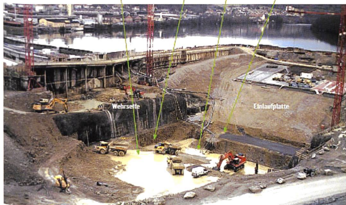
Bild 3. Schematische Lage des Maschinenhauses in der Baugrube.
