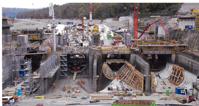
Bild 5. Unterwasserauslauf Saugrohrstrukturen Maschinen 1–4.
