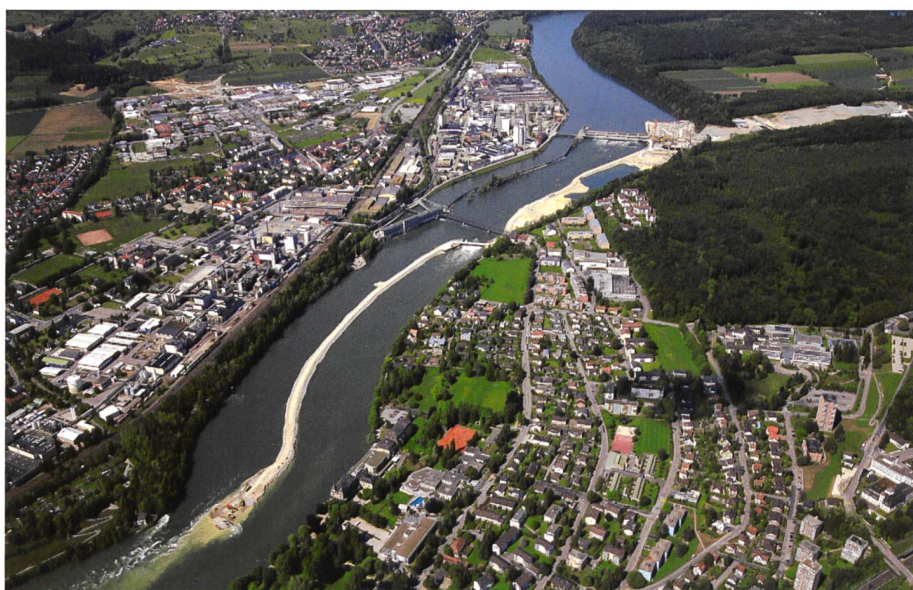
Bild 1. Unterster Punkt der Rheineintiefung im Mai 2009.
