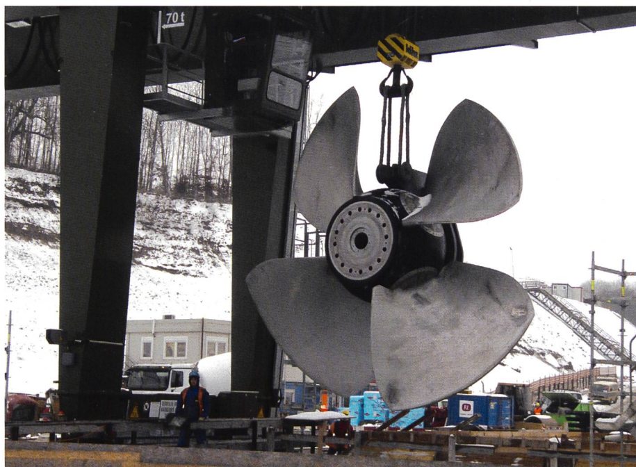
Bild 9. Einheben des ersten Turbinenlaufrades.
