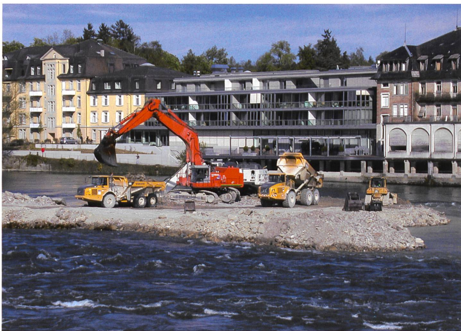
Bild 2. Mit vier Kubikmeter fassenden Löffeln beluden die drei 130 t-Bagger sieben Dumper, die das Material zu den Deponien brachten.
