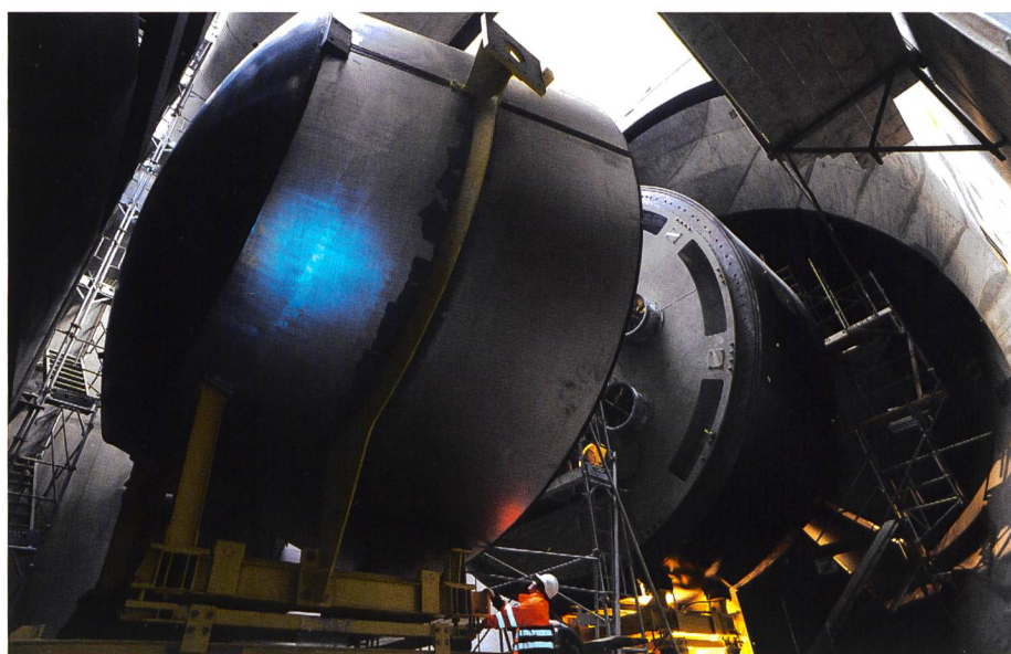
Bild 10. Zusammenschieben des Generatorstators über den Rotor.
