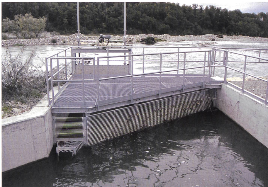
Bild 1. Zählbecken im Umgehungsgewässer KW Rheinfelden (Foto: SWV/Pfa).
