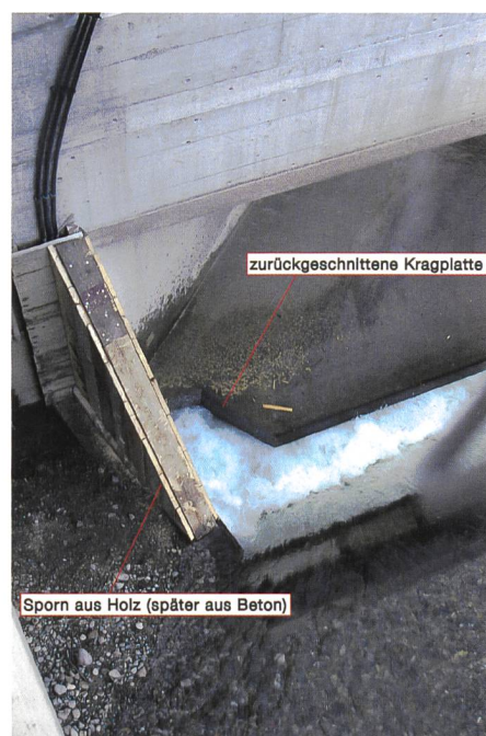
Bild 10. Zusätzliche Massnahmen zur Geschiebeabwehr an der Fassung: a) Zurückschneiden der Kragplatte und b) Sporn aus Holz.
