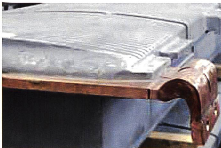
Bild 5. Erneuerung einer defekten Dämpferverbindung.
