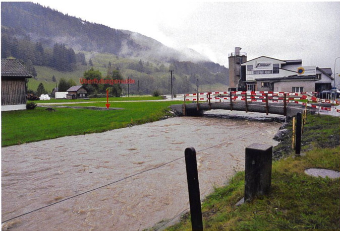
Bild 12. Ausgebautes Gerinne der Säntisthur mit der neu erstellten Brücke Langhans. Die Entlastung entlang des linken Ufers ist 2011 nicht angesprungen.
