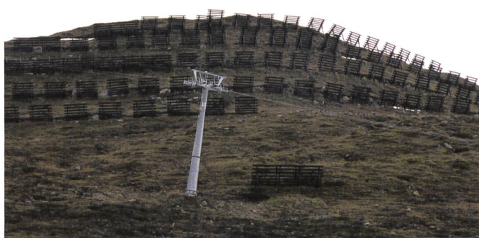
Bild 2 (links) und Bild 3 (rechts). Lawinenverbauungen vor den ersten Montagearbeiten, Standort Pilot-Band, (Quelle: Graf, 2012).
