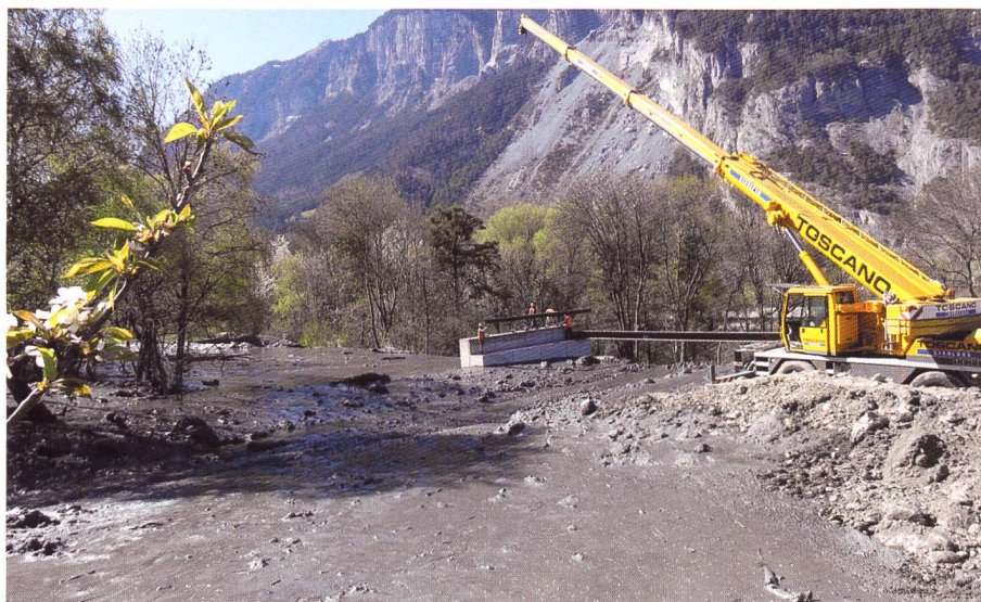
Bild 5. Geröllmassen, Schlamm und Holz wurden ab Mitte April aus dem Val Parghera GR ins Tal verfrachtet. Eine Notbrücke wurde gebaut (Foto: Norina Andres, WSL).
