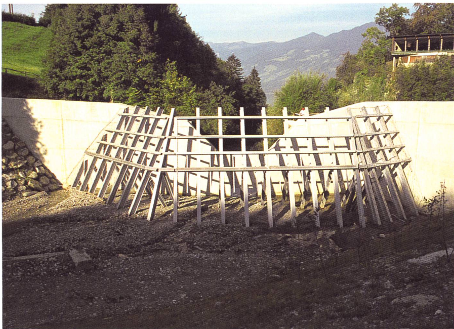
Bild 3. Geschiebesammler am Dorfbach von Sachseln mit Grobrechen zum Schutz vor Geschwemmseil. Die kleine Durchlassöffnung staut den Sammler schnell ein, sodass die Geschiebedurchgängigkeit bereits bei kleineren Hochwasser nicht mehr gewährleistet ist (Photo Dr. Martin Jäggi).
