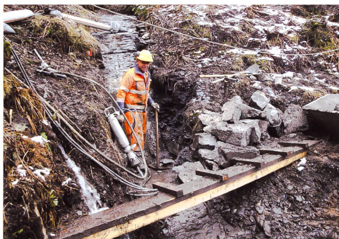
Bild 3. Abbrucharbeiten an einer der Quelfassungen Anfang November 2013.
