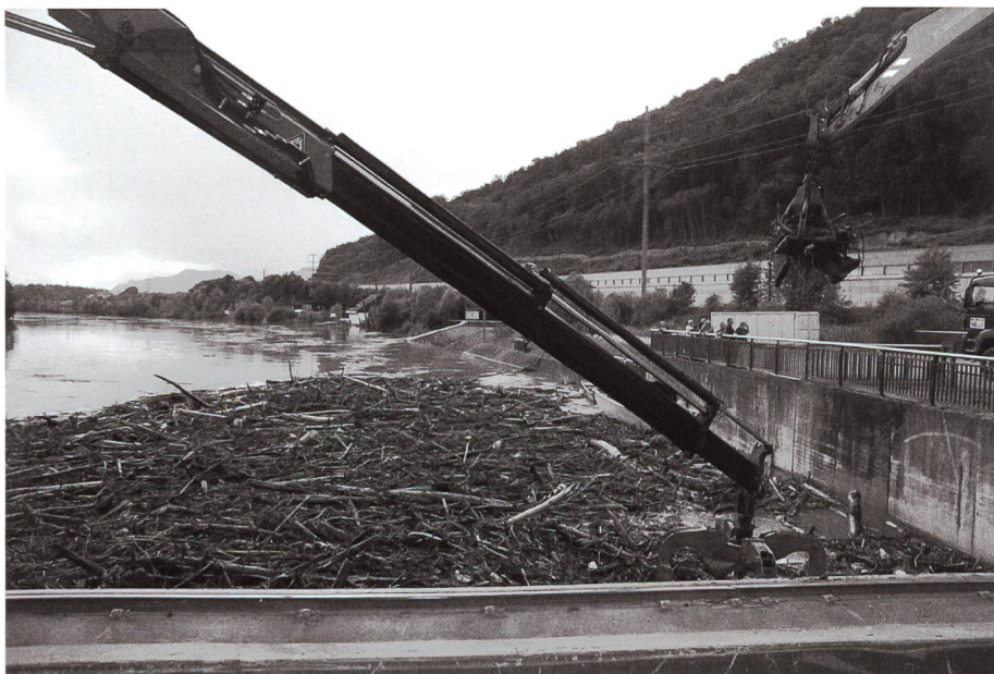
Bild 18. Geschwemmselelntnahme beim Kraftwerk Ruppoldingen im Juli 2014.
