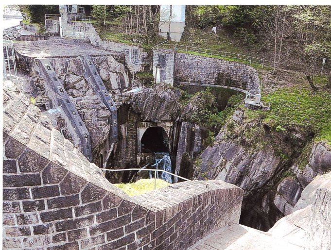
Bild 5. Blick auf die Hochwasserentlastung der Sperre und den Auslauf des SBT Pfaffensprung (Foto: VAW).
