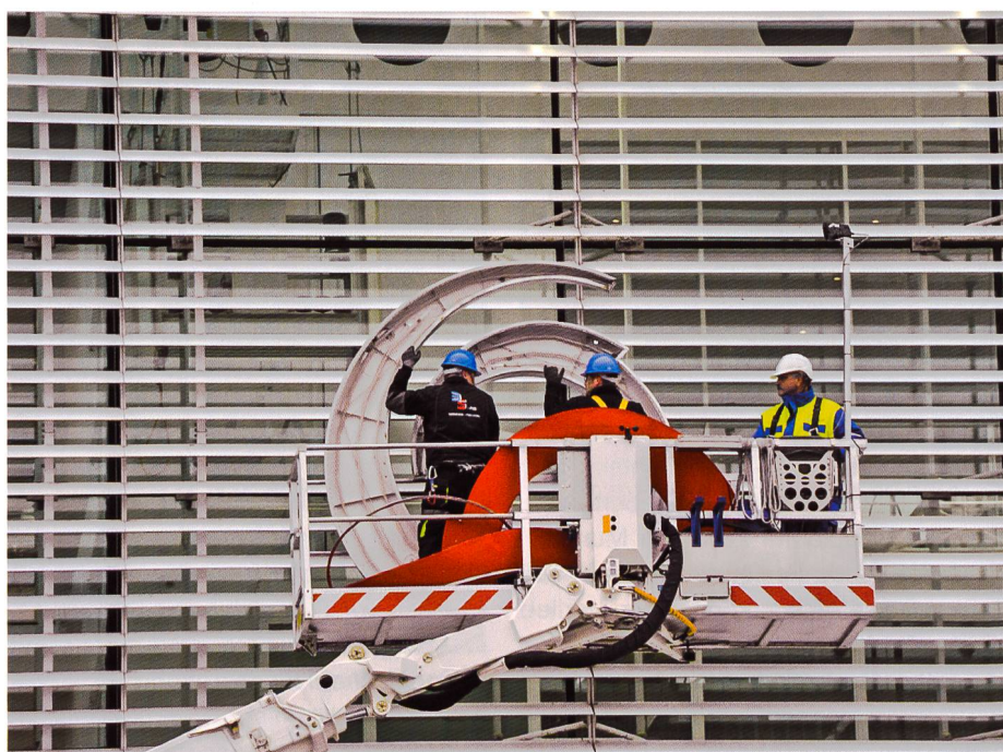
Aufnahmen vom Rebranding des Alstom-Gebäude in Baden.
