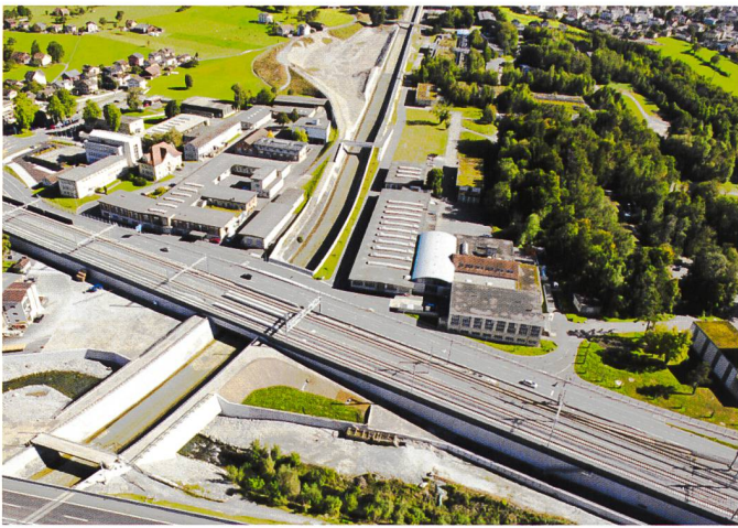
Bilder 3a und 3b. Neuer Geschiebesammler mit 80 000–90 000 m 3 Fassungsvermögen.
