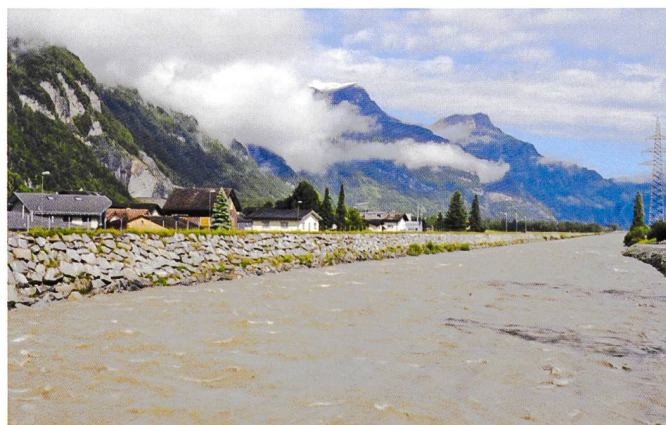
Bild 9. Erhöhter Reussdamm bei Attinghausen.
