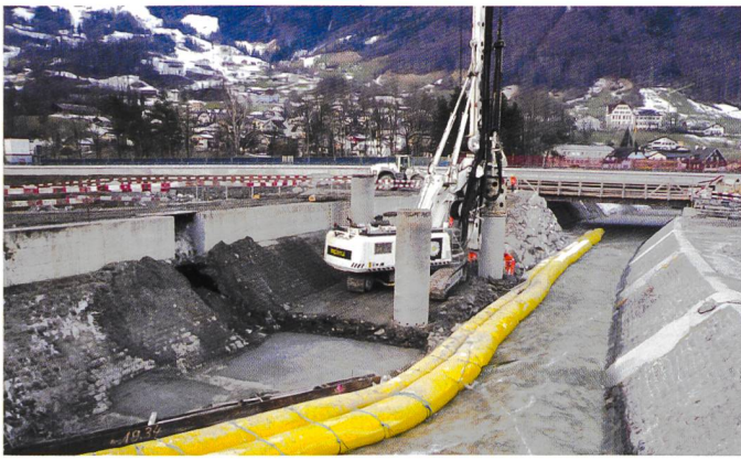
Bild 1. Erstellen der Bohrpfähle im Schächen.
