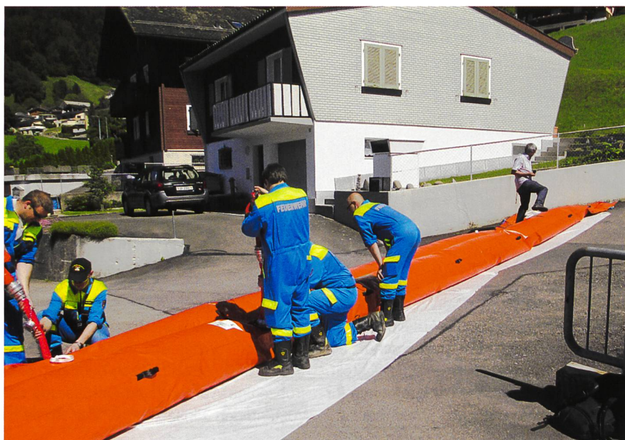
Bild 3. Einbau Beaver-Schläuche.
