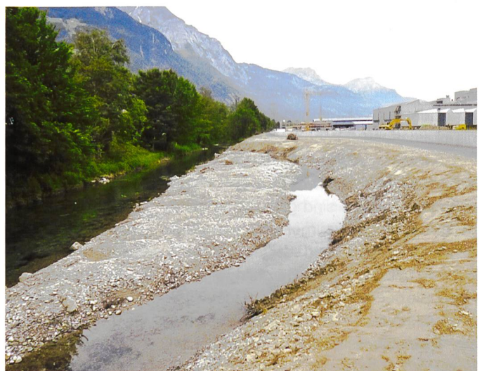
Bild 2. Rechtsufrige Aufweitung an der Stillen Reuss (Foto Duwaphan).
