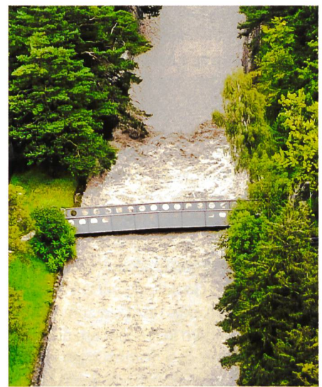
Bild 2. Der Wassersprung ob der Passelle markiert die Front der gegen die Fliessrichtung wandernden Auflandungsfront (Aufnahme am 23. August 2005, Vormittag. Copyright TBA Kanton Uri).
