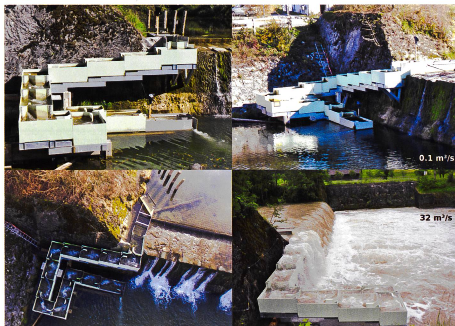
Bild 1. Fischtreppe Steffstep in der Töss bei Kollbrunn, Kanton Zürich.
