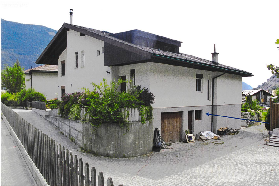
Bild 6. Angeströmte Fassade des Wohngebäudes Nr. 16. Die Anströmrichtung ist mit einem blauen Pfeil gekennzeichnet (Foto Martin Seiler).
