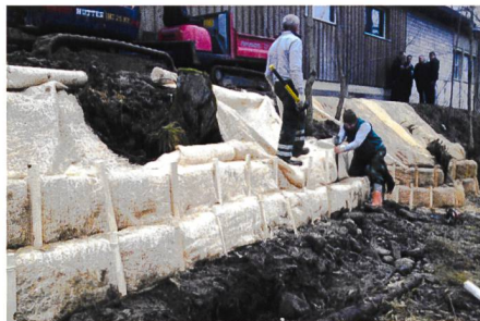
Bilder 2,3,4. Howolis-Q-Faschine: Verlegung der Q-Faschinen, Verpflockung und Befestigung der Faschine entlang des Ufers.
