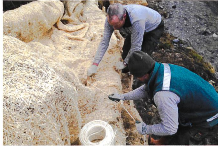
Bild 5. Howolis-Q-Faschine: Die flexiblen Holzwolle-Faschinen erlauben die Verlegung entlang der individuellen Uferlinie. Ebenso lassen sich Rauigkeitselemente wie Kleinbuhnen und Sporne modellieren.
