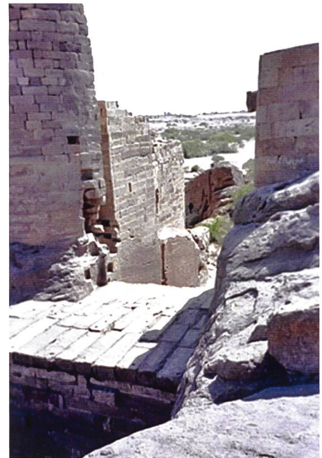
Bild 8. Rechte Talseite mit Schleusenbauwerk, (Quelle; Wikipedia, angepasst von Robert Widmer).
