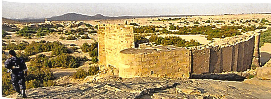
Bild 7. Linke Talseite mit Schleusenbauwerk, (Quelle; Wikipedia, angepasst von Robert Widmer).
