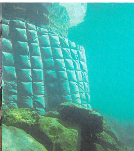
Ufermauer nach Sanierung.
