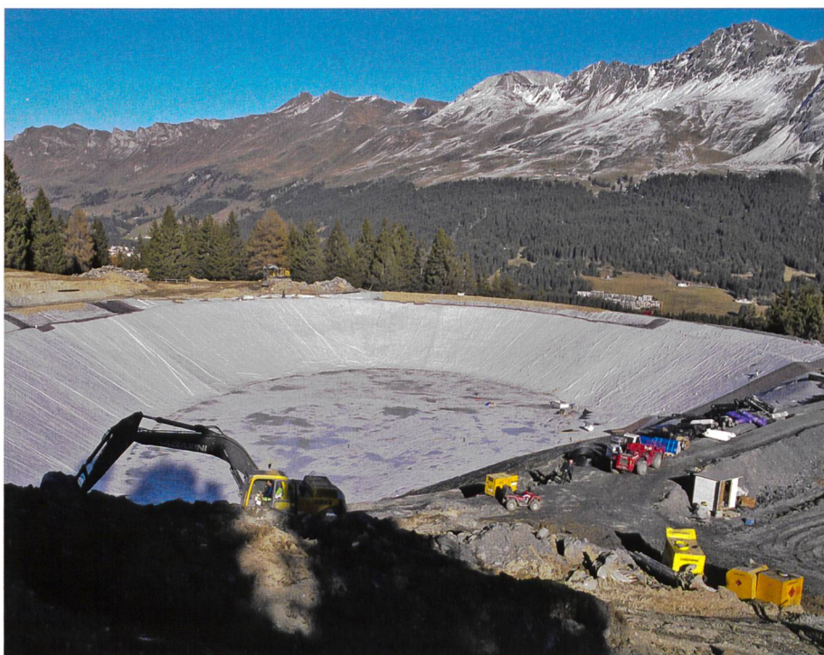
Bild 1. Bau des Beschneigungsteichs Valos, Lenzerheide, Kanton Graubünden, 110000 m 3 , (Quelle: FHP, Bauingenieure AG).
