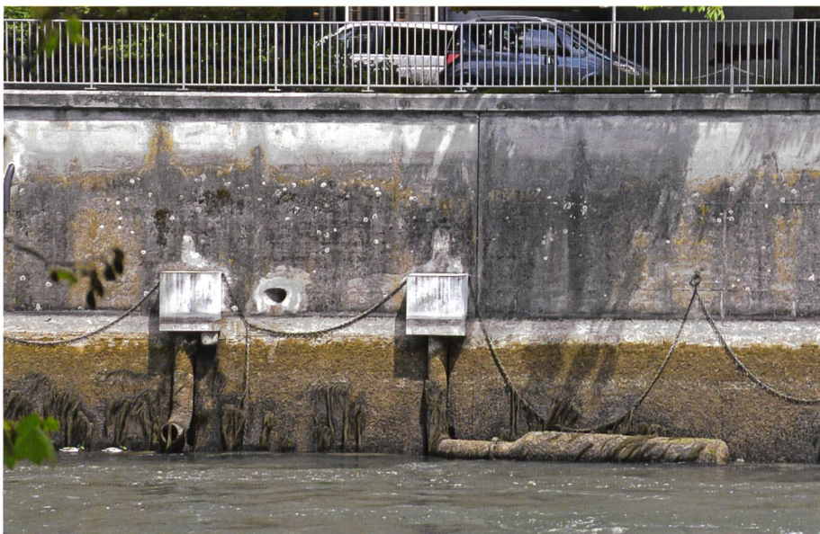
Bild 3. Freigelegte Kühlwasserentnahme oberhalb des Platzspitzwehrs, Fliessrichtung von rechts nach links. Rechts die Fassung mit dem Seiher, links die Rückgabe (Quelle AWEL).
