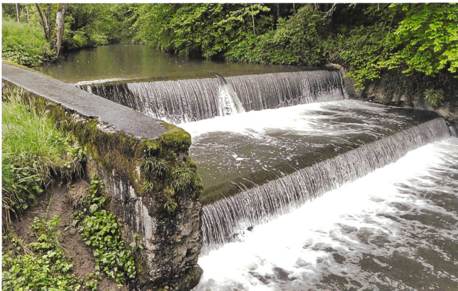
Bild 2. Das alte Wässerungswehr in der Surb mit einer Überfallhöhe von insgesamt 2.3 m.
