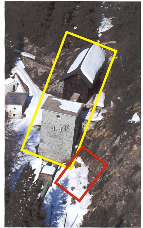
Gebäudekomplex Puntalta (Foto mit Standorten alt [gelb] und neu [rot]) / Disposition neues Apparategebäude.
