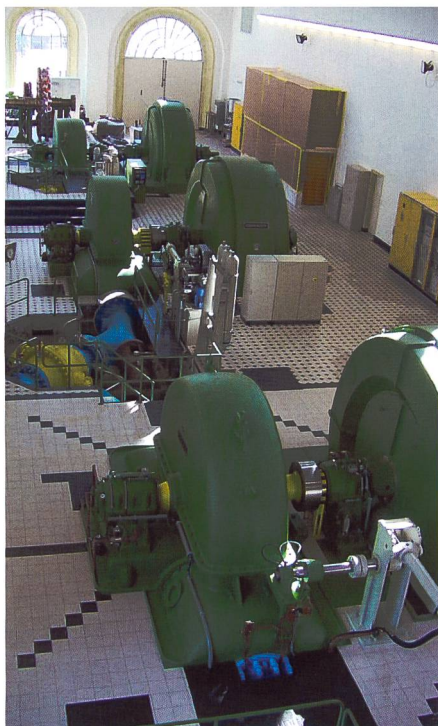
Bestehender Maschinensaal KW Robbia.
