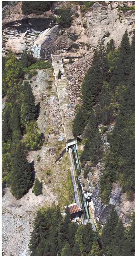
DL Balbalera, bestehende Steinschutzgalerie über den Druckleitungen.
