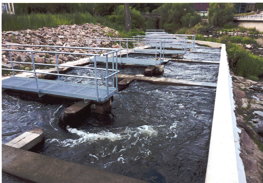
Bild 6: Konventioneller Schlitzpass mit alternierender Beckenführung (Foto: www.ib-handrick.de).
