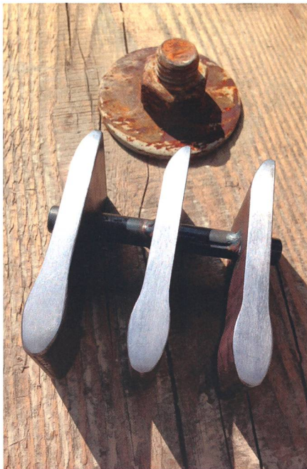
Abbildung 2: Teilstück Fischleitrechen.
