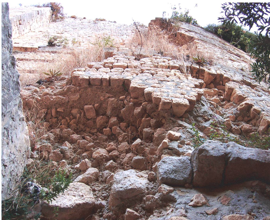
Bild 7: Beschädigte zylindrische Stauwand.
