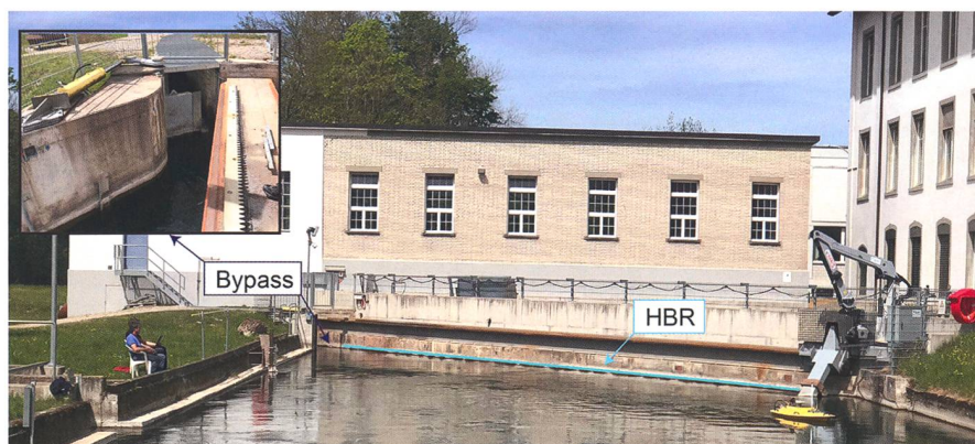
Bild 1: Das Laufwasserkraftwerke Stoppel in der Gemeinde Untertürkmen (AG) ist mit einem horizontalen Fischleitrechen (HBR) ausgerüstet, der die in der Limmat lebenden Fische (u. a. Schneider, Barben und Rotaugen) in einen Bypass leitet, damit sie am Kraftwerk vorbei flussabwärts wandern können. Bei grösseren Laufwasserkraftwerken werden Fischleitrechen bisher in Europa nicht eingesetzt (Foto: Ismail Albayrak, VAW).
