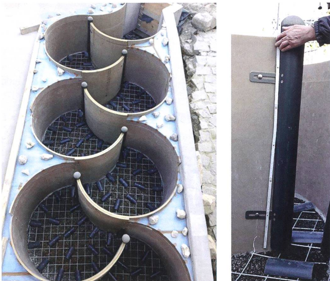
Figure 3: A gauche: arrangement et conception de bassins de type C (en construction); à droite: disposition d'une fente verticale (Barrage sur l'Echaz, Reutlingen; photos: J. Stork).
