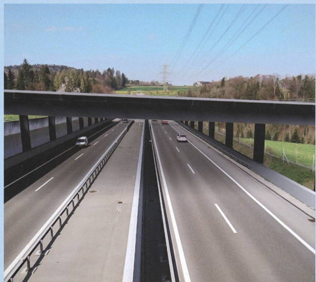
Bilder 9 und 10: Fotomodelle zur Überdachung von Teilstrecken der Autobahn A4 mit Solarpanels. Quelle: Servipier AG.
