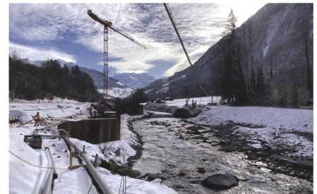
Baustelle Kraftwerk Augand an der Kander. Foto: BKW.
