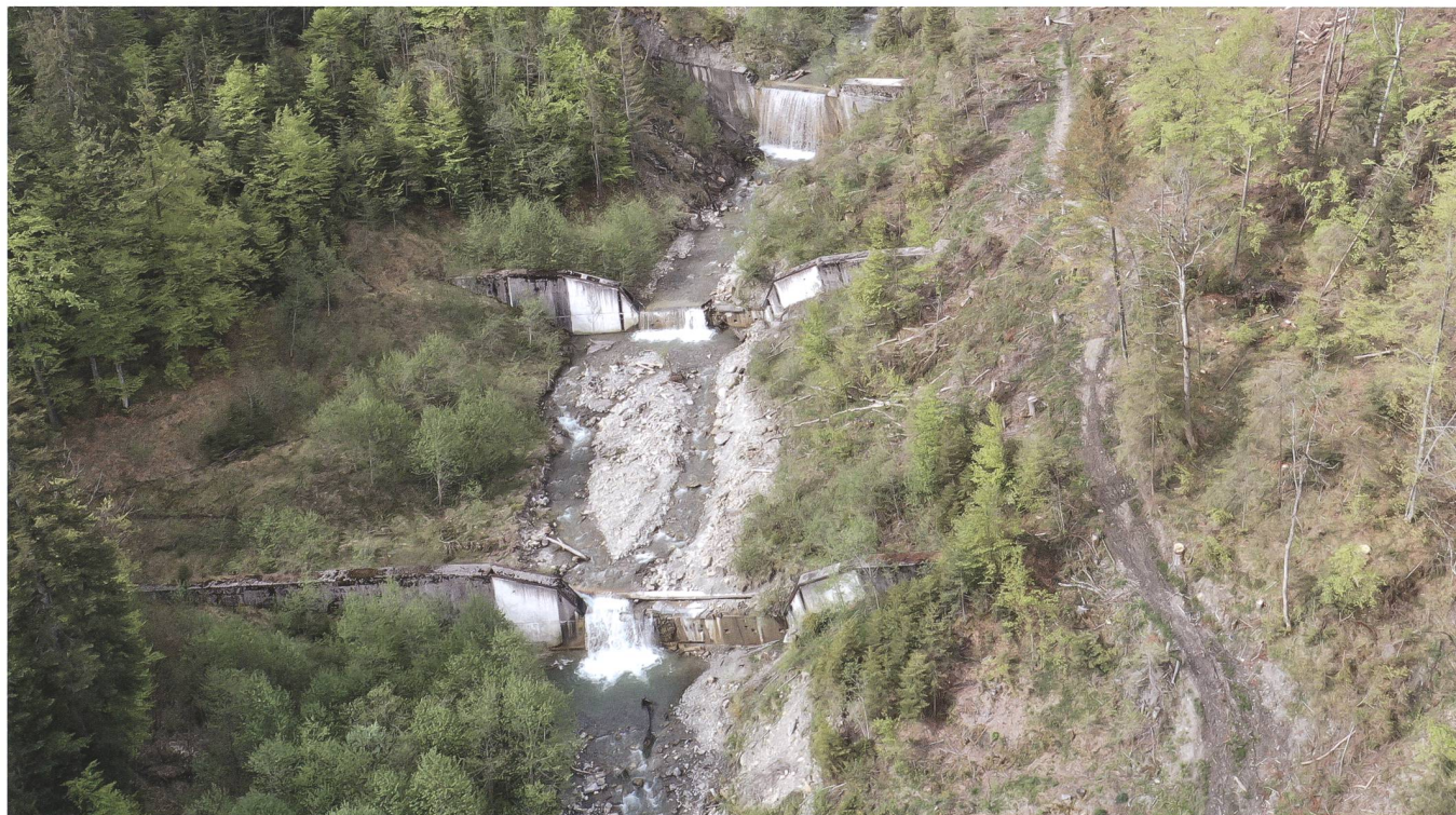
Stark beschädigte Sperren im Gebiet der Meierisli-Rutschung. Die unterste Sperre 33 ist im Bild unten auf Seite 173 im Detail zu sehen. Foto: Jürg Speerli.
