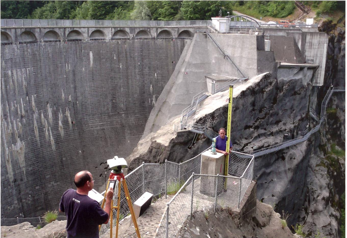
Bild 6: Staumauer Montsalvens 2014: Alain Wicht und Jean Ecoffey bei Nivellementmessungen beim Pfeiler 1. (M. Kistler, © Bundesamt für Landestopografie swisstopo).
