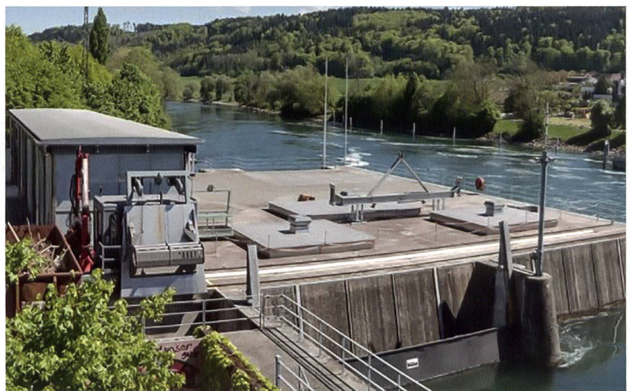
Erneuerung Wasserkraftwerk Brügg. Bild: Bielersee Kraftwerke AG
