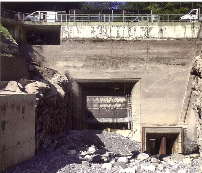
Bild 3: Oberwasseransicht des Stauwehrs Schlattli im Ausgangszustand. Oben links: Öffnung der Stauklappe mit Schwimmerschacht, Mitte: Haupt- und Regulierschütze, unten rechts: Grundablässe 1 und 2.
