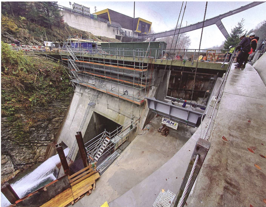
Bild 16: Einheben der Stauklappe mit einem Pneukran auf dem Vorplatz der Stoosbahn (oben links).
