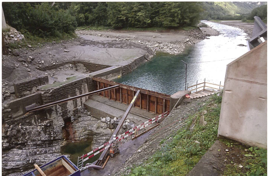
Bild 9: Bauwand im Oberwasser des Stauwehrs Schlattli auf der Schwelle der alten Wasserfassung zur Umleitung der Muota durch den Umleitungsstollen (Aufnahme während des Einstauversuchs).
