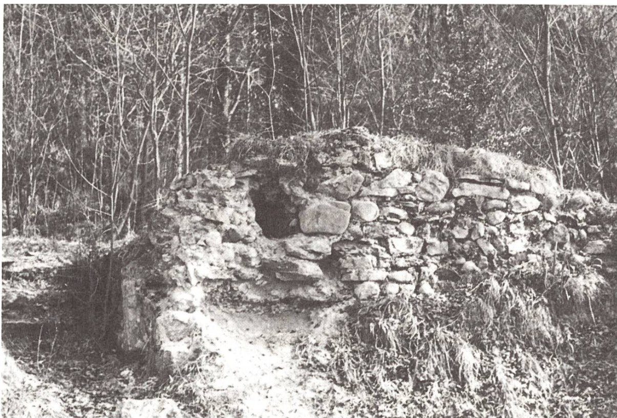
Mauerreste des Hauptgebäudes mit Balkenloch und links der Eingang vom Burghof her.
