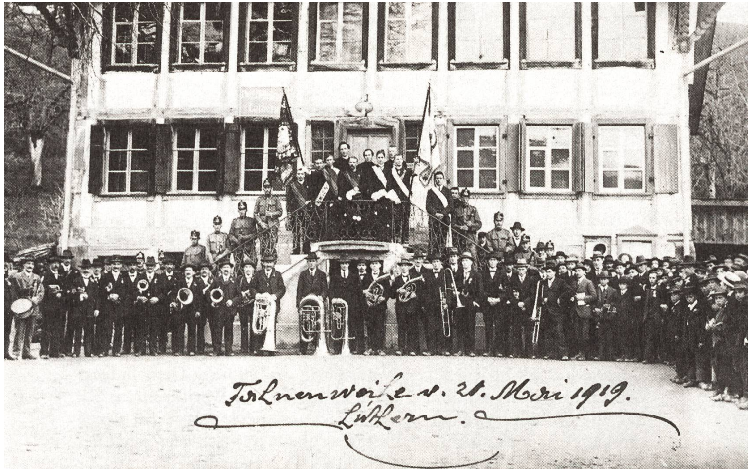
3 Gemeindehaus zur «Wölfen» 1919.
