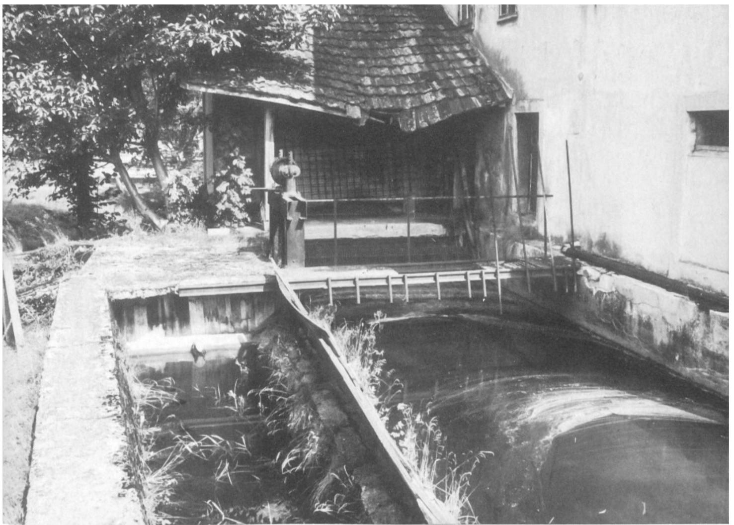
Oberwasserkanal und Turbinenbau, Burgrain.
