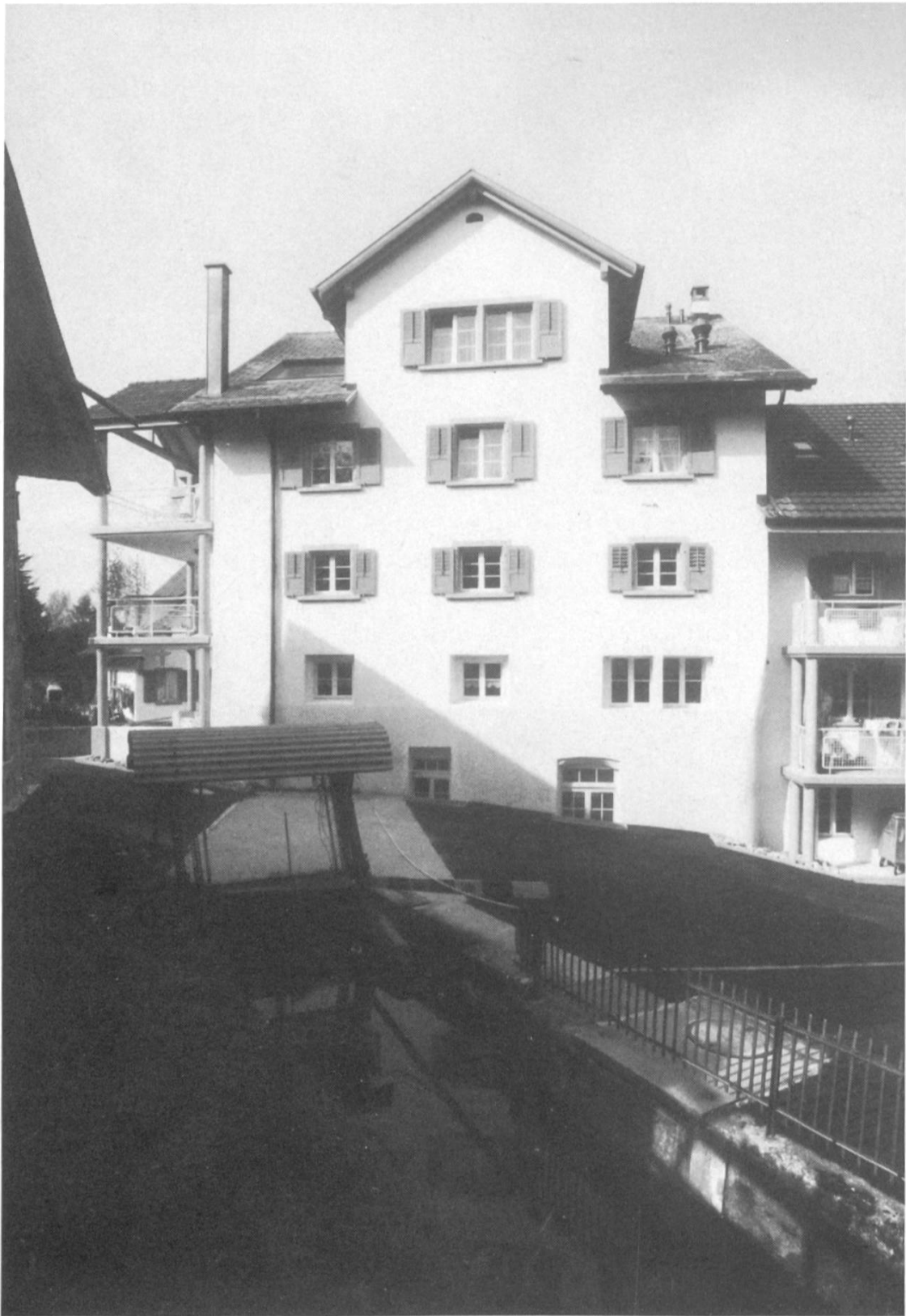
Dorfmühle mit Rechenanlage und Kanaleinlauf, Schötz.
