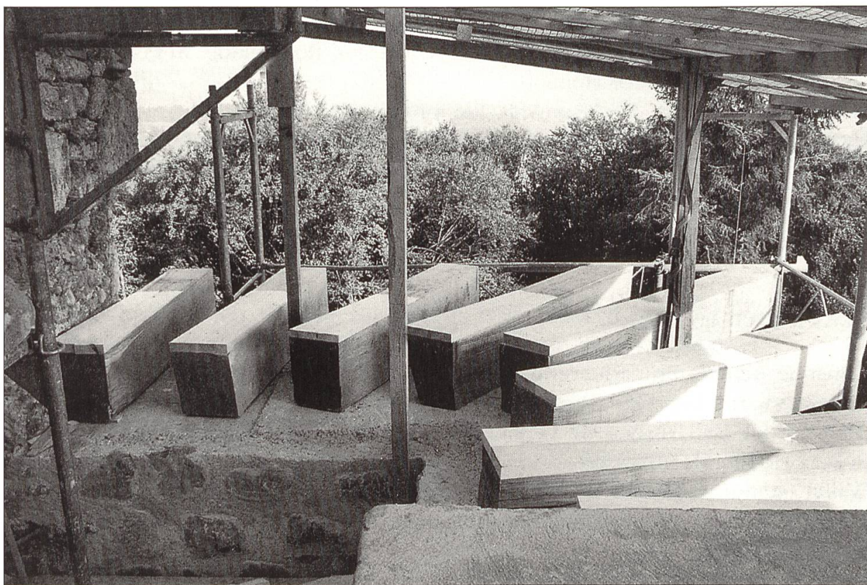
Die mächtigen Eichenbalken sollen an den früheren Eckturm-Aufbau erinnern. Foto: Ferdinand Andermatt
