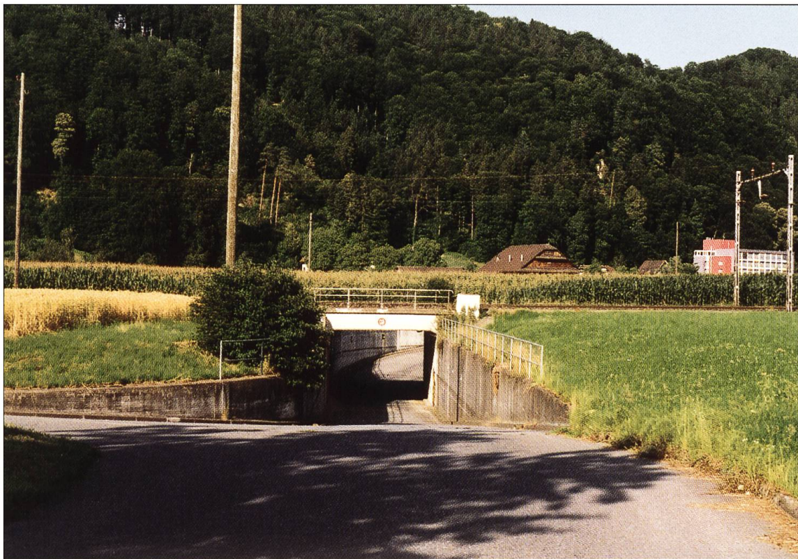
Die Unterführung der Zufahrtsstrasse zu ARA.
