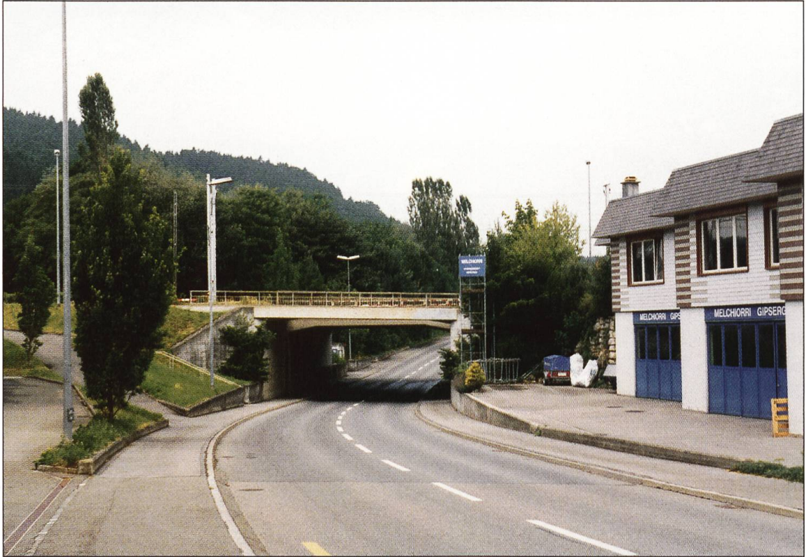
Die Unterführung der Langnauerstrasse unter der SBB-Linie.
