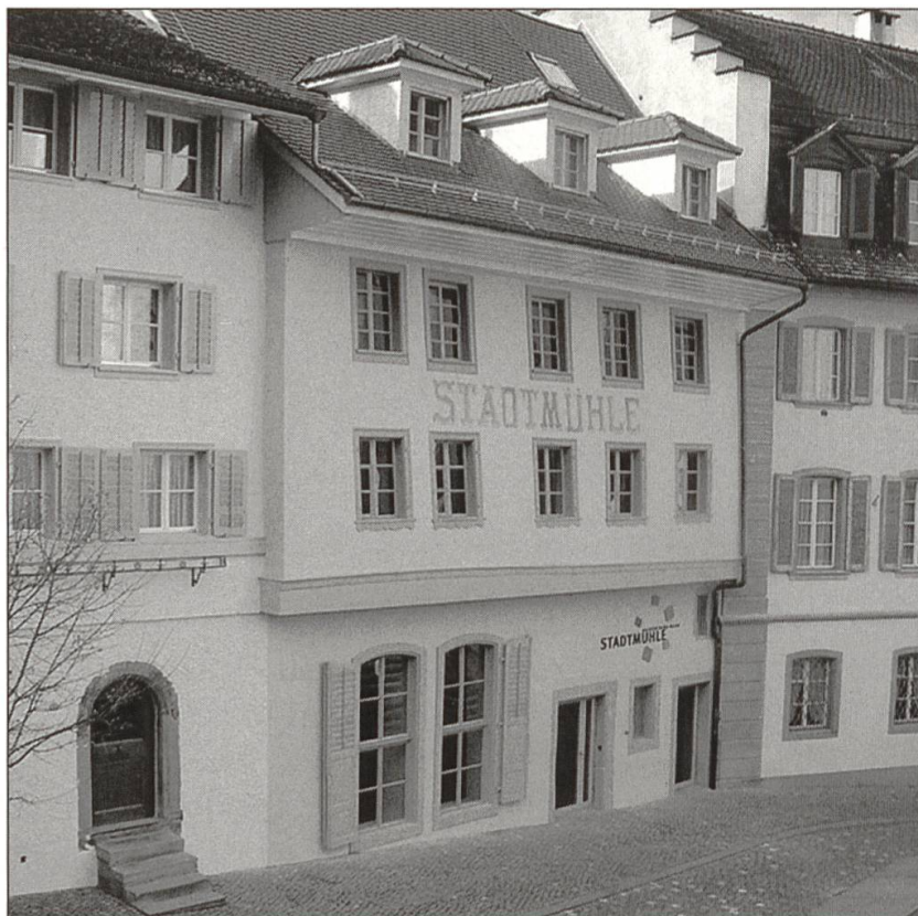
Ostseite der Stadtmühle nach der Renovation.
