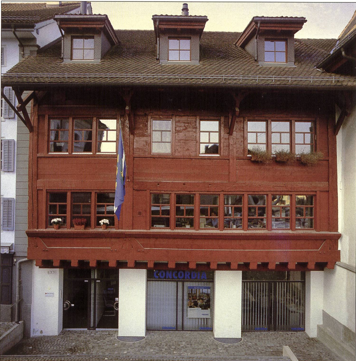
Abbildung 16: Das restaurierte Haus Müligass 2 von 1471/72.
