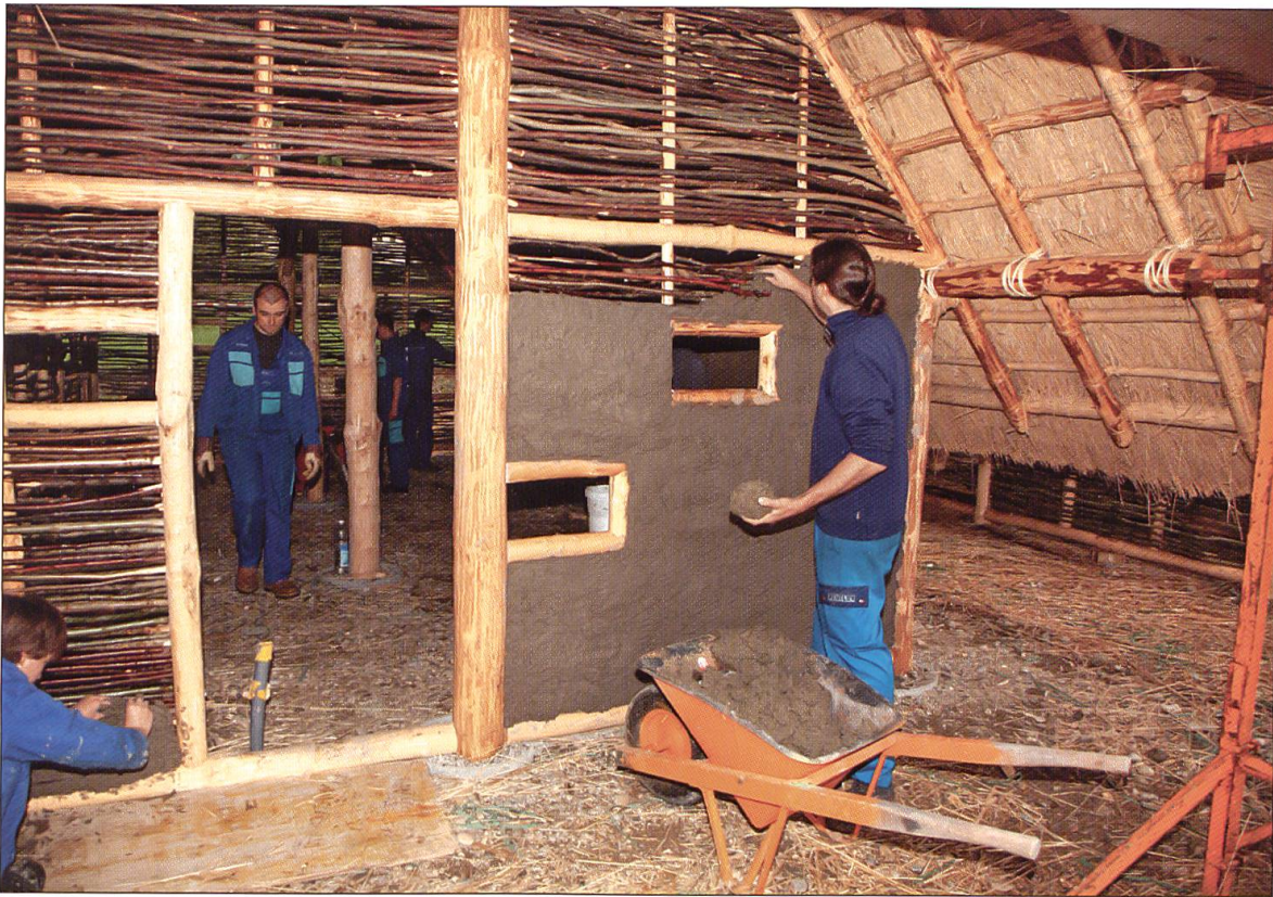
Fachmännisch werden die Mauern verputzt.
