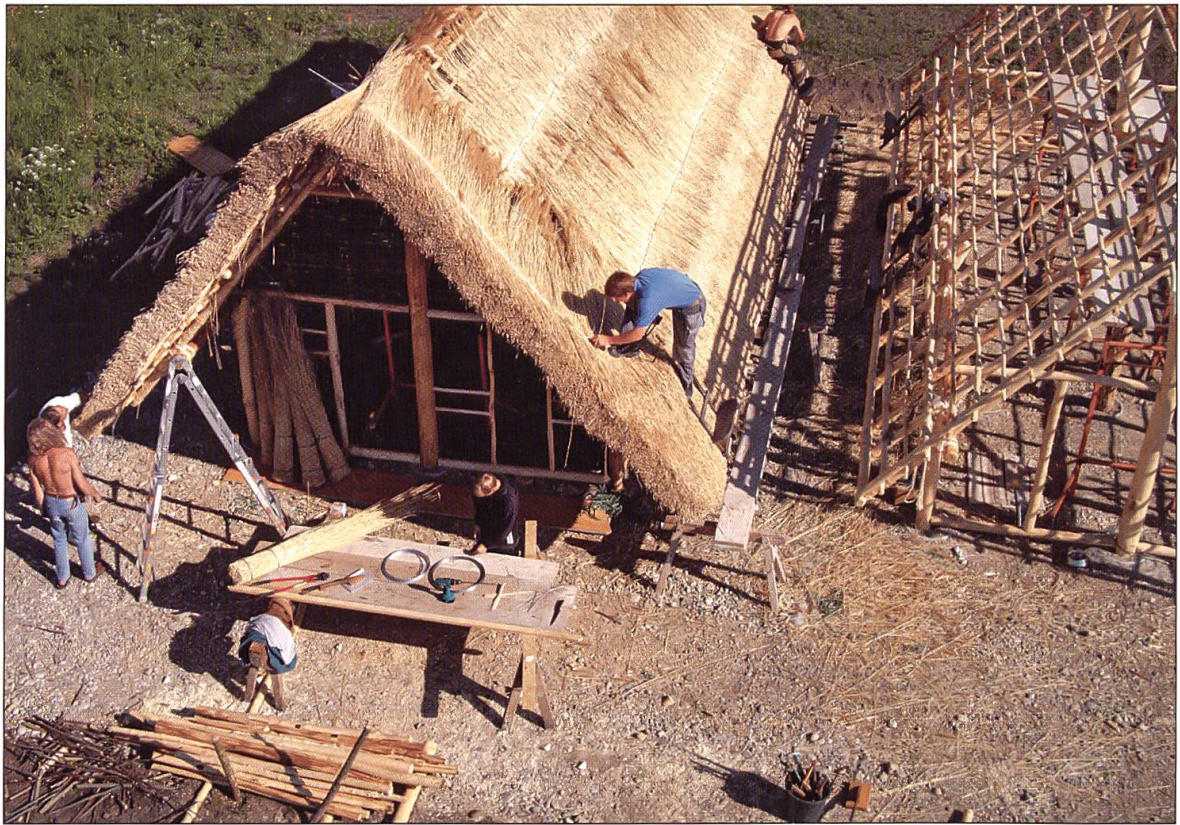
Die Bauten werden gedeckt.
