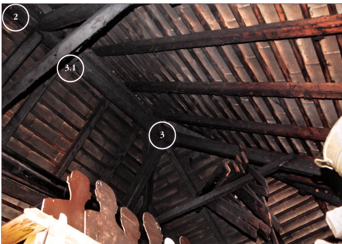
3.1 Firstverblattung Längsverstrebung zu Hochstud 3.
