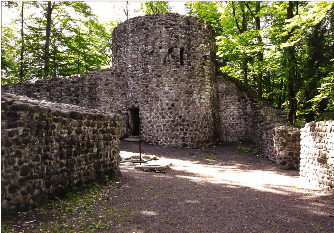
Die Ruine der Wildenburg, im 13. und 14. Jahrhundert einer der wichtigsten Sitze der Hünenberger, liegt auf einem Felsporn im Lorzentobel, auf der halben Strecke zwischen Baar und dem Ägerital. Sie ist als die einzige gut erhaltene Burganlage im Besitz des Kantons Zug. Zwei Fusswege führen zur ummauerten Anlage mit mächtigem Turm.
