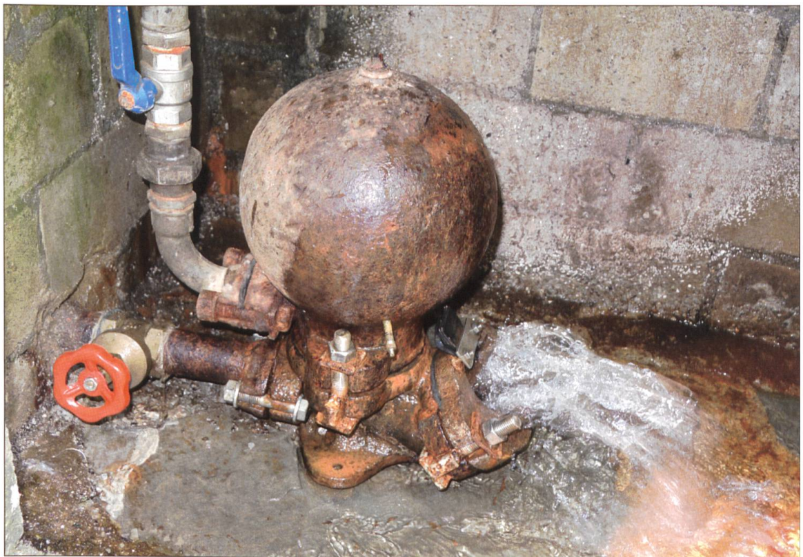
Die Widder bei der Willisauer Bunegg laufen in den erneuerten Unterständen wieder wie eh und je. Hier eines der drei fast identischen Modelle, Ventil zu und offen.
