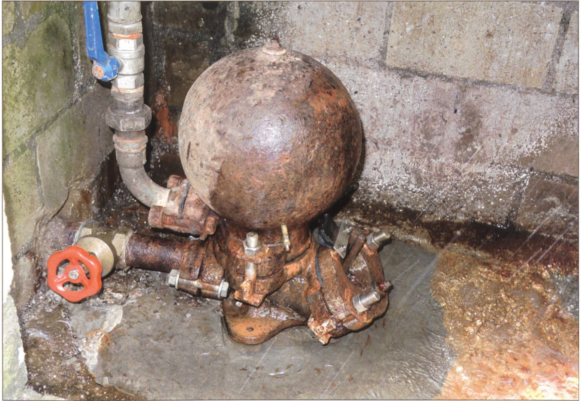
Die Widder bei der Willisauer Bunegg laufen in den erneuerten Unterständen wieder wie eh und je. Hier eines der drei fast identischen Modelle, Ventil zu und offen.
