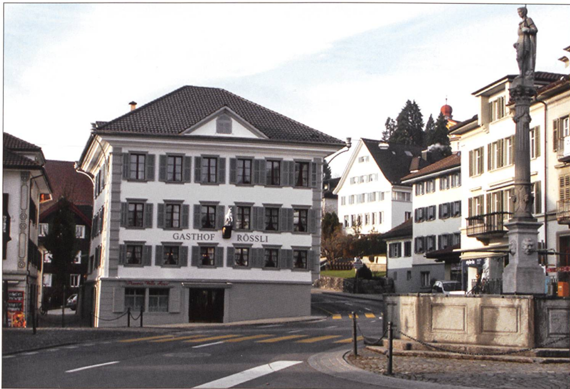
Das Gasthaus Rössli nach der Fassaden-Renovation von 2004.
