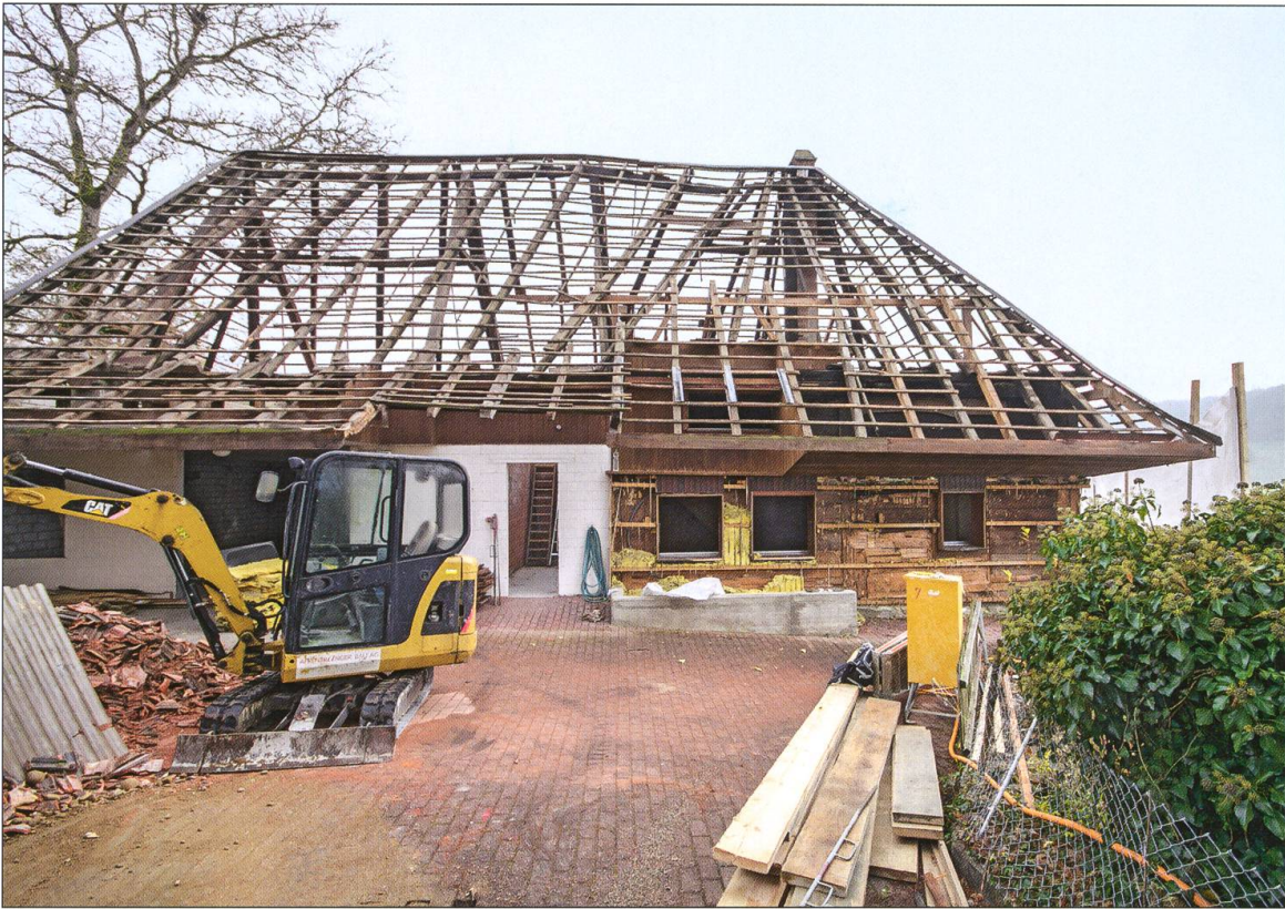
Ansicht der Westfassade, November 2019.
