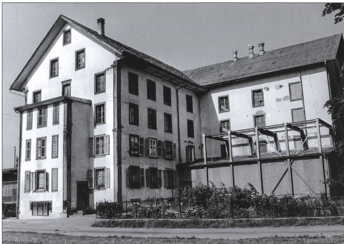
Kunstmühle in Alberswil: Im Hinblick auf das Bahnprojekt Nebikon–Willisau bauten die Steiners diesen markanten Mühlenbau, um bessere Transportmöglichkeiten zu schaffen. Dieses Gebäude verfügte neben einer neuartigen Mahleinrichtung auch über eine Siloanlage. Ebenfalls befanden sich in diesem Bau eine Wohnung für den Obermüller und Schlafgelegenheiten für die Angestellten.
